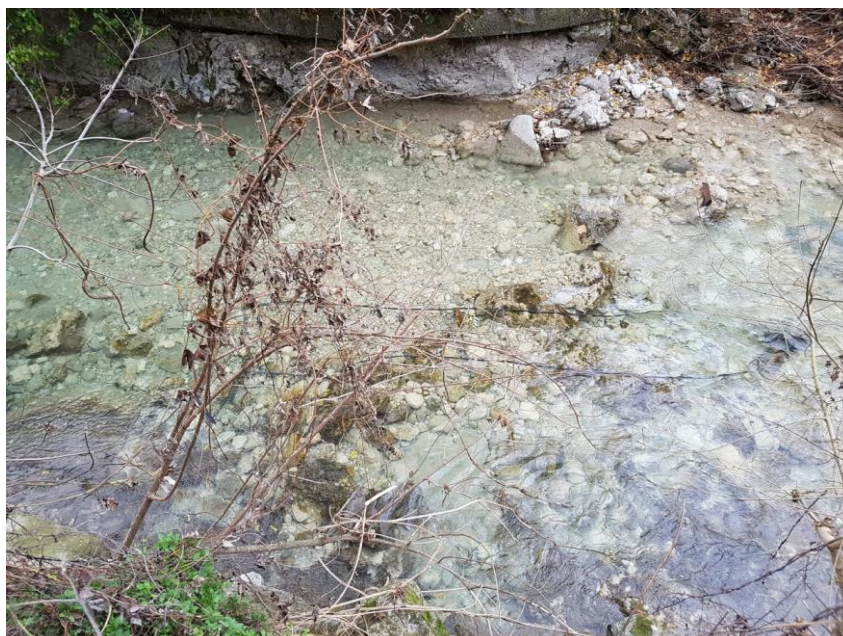
Figure 15: Antenne au Pont des Salles post crue
